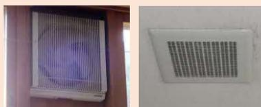
壁付け換気扇 天井埋込形
